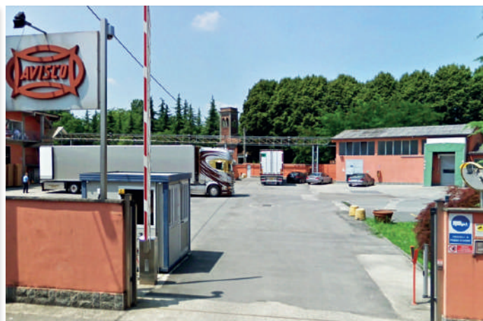
Rivolta d'Adda (CR) Avisco S.p.a. Mini Chiller da 16 kW
