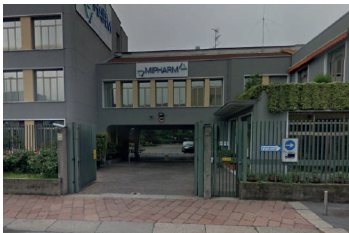
Milano Mipharm S.p.a. Sistema VRF da 45 kW
