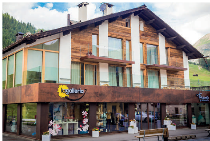
Livigno (SO) La Galleria Sistema VRF da 73,5 kW
