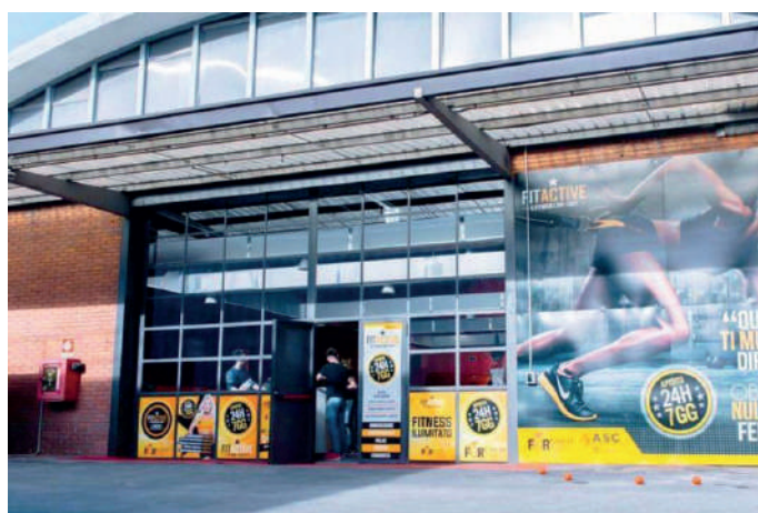
Cantù (CO) Palestra FitActive Rooftop da 105 kW
