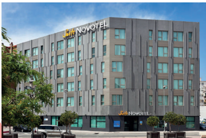
Malaga (Spagna) Hotel Novotel Sistema VRF da 90 kW
