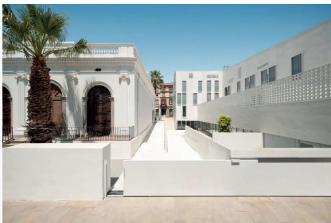
Vilassar de Mar (Spagna) Centro Can Bisa Sistema VRF da 118 kW
