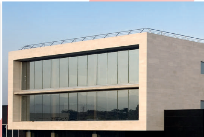
Paret del Valles (Spagna) Centro negozi del Valles Sistema VRF da 33,5 kW
