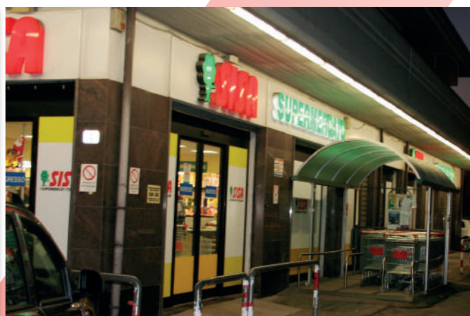
Napoli Supermercato SISA Sistema VRF da 100,5 kW
