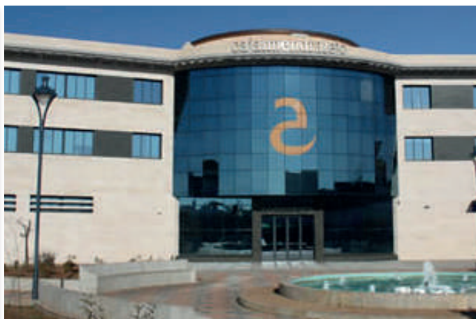
Caceres (Spagna) Centro servizi di Caja Almondralejo Sistema VRF da 28 kW + Rooftop da 67 kW
