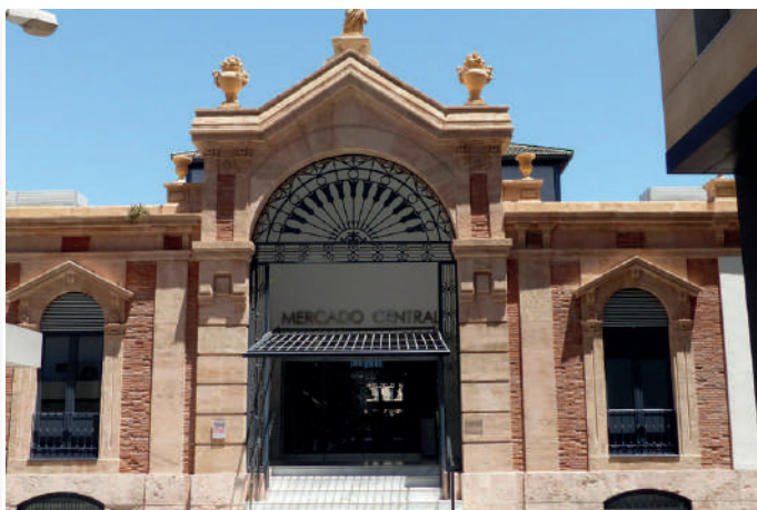
Almeria (Spagna) Mercato alimentare centrale Sistema VRF da 674 kW
