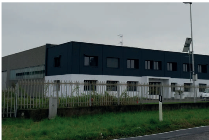
Vertemate con Minoprio (CO) Lariotex S.r.l. Sistema VRF da 70 kW
