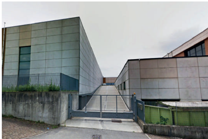
Osnago (LC) Energy Solution S.r.l. Mini Chiller da 16 kW
