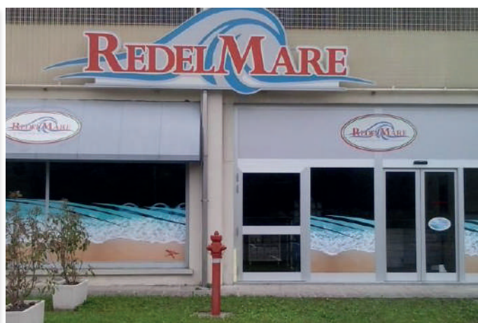
Castione Andevenno (SO) Re del Mare Sistema VRF da 45 kW
